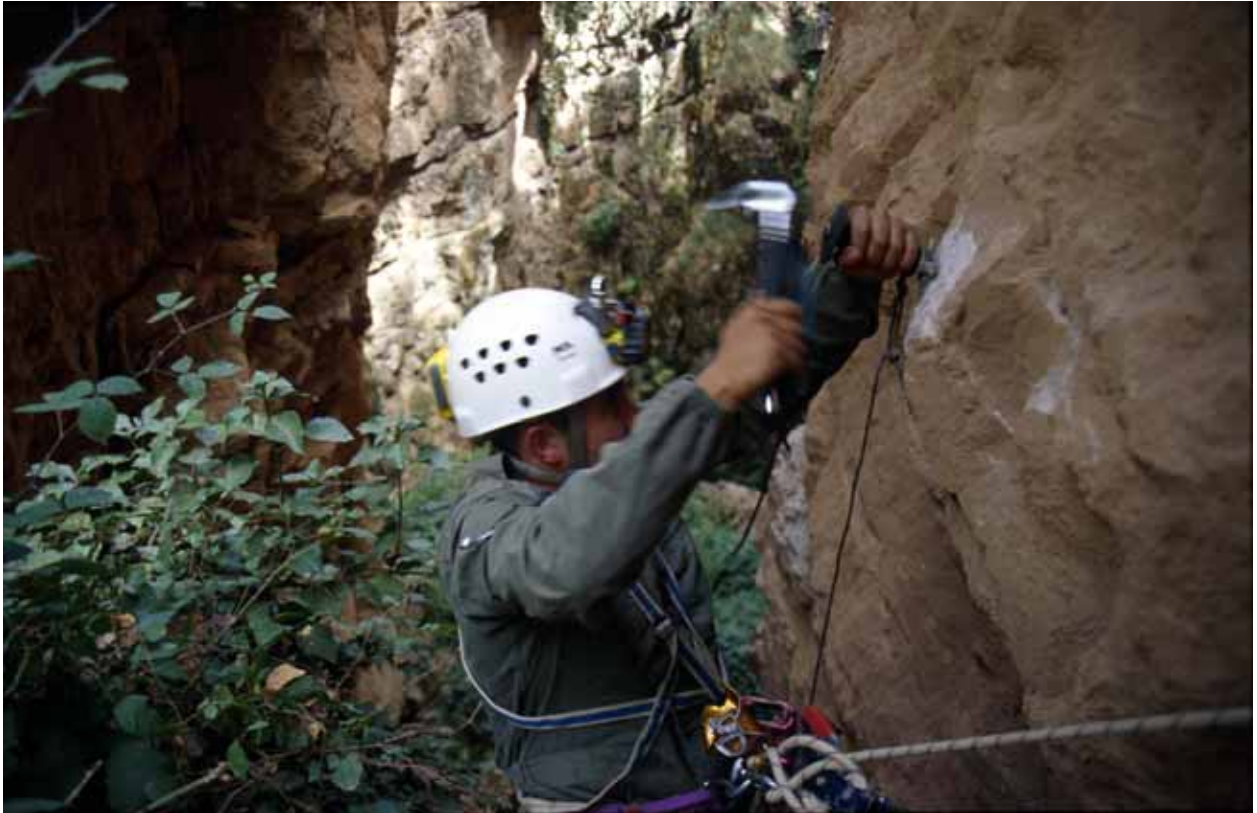
Instalando una cabecera artificial
