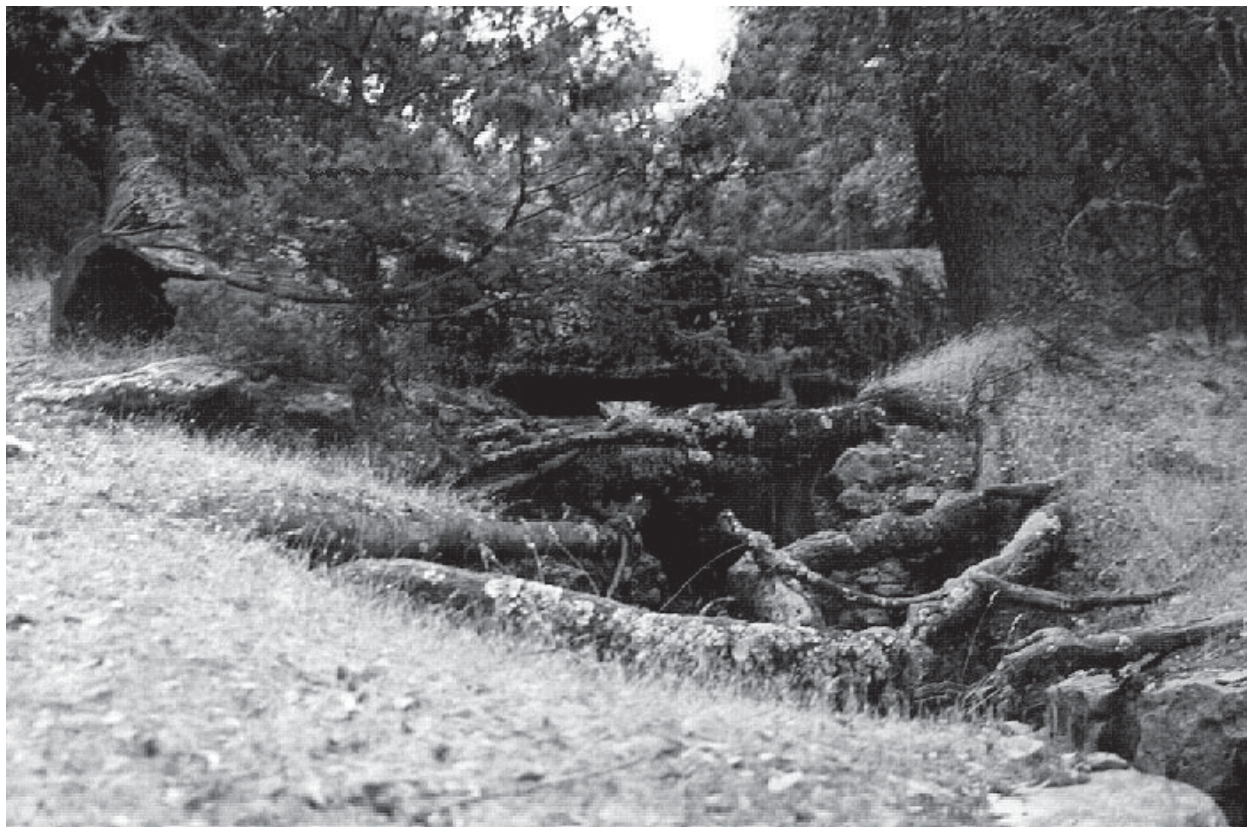
Raíces de cedro cruzando una grieta
