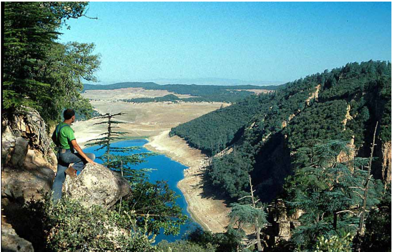
Vista del lago en la que podemos apreciar las enormes grietas del monte Tardare (a la derecha).
