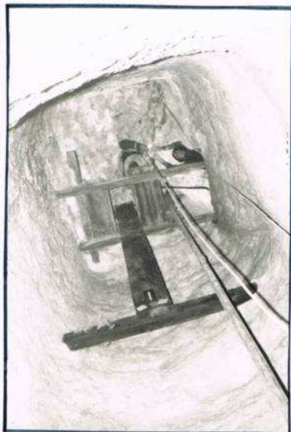
.- Aspecto del pozo de 8 metros.
