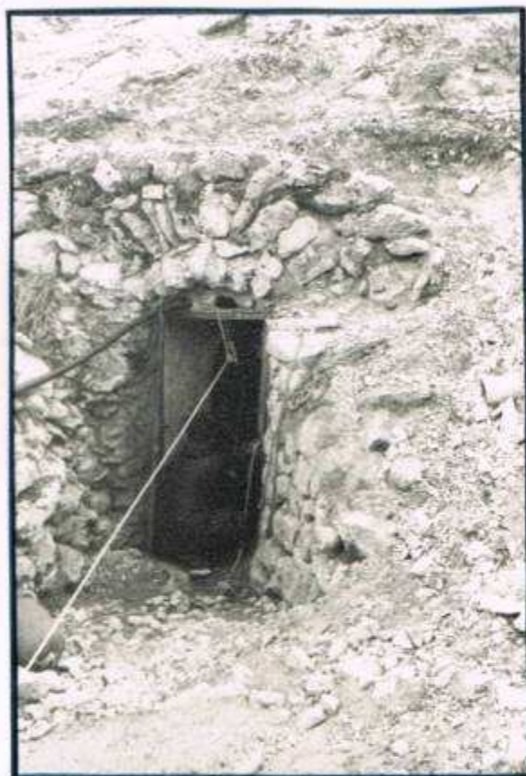
.- Boca de acceso
