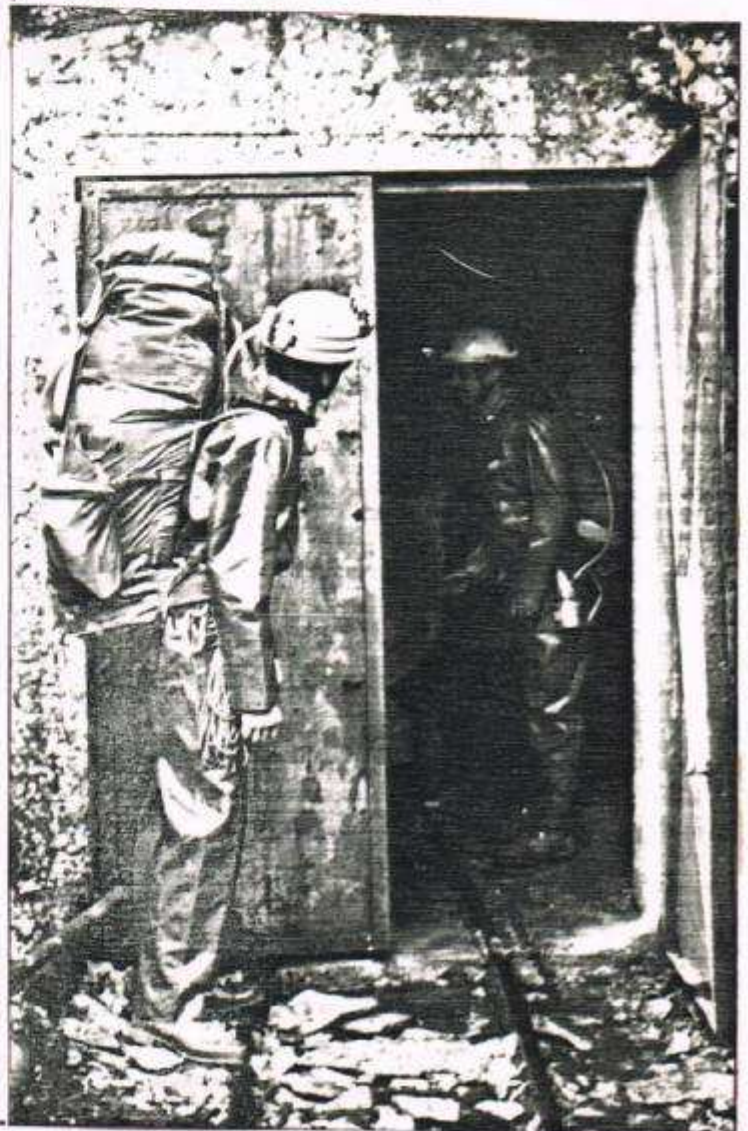
Entrada del tunel de la E.D.F. que da acceso a la S. La Verna
