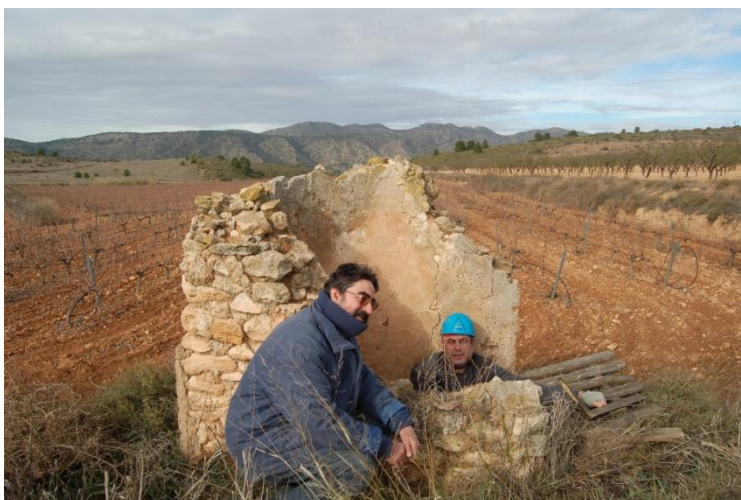
Caseta del pozo 1, que protegía de la superficie la construcción
