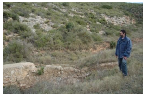
Presa de captación
